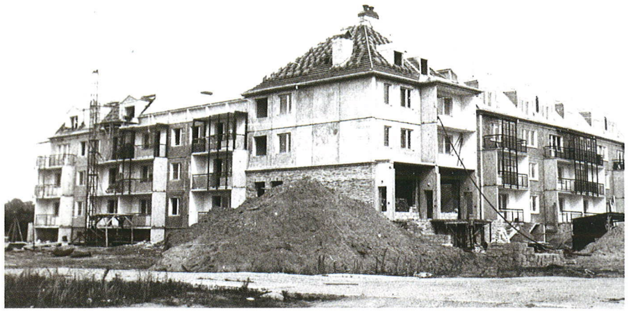
Powstają bloki na rogu ulic Krętej i ówczesnej ulicy Kasztanowej
